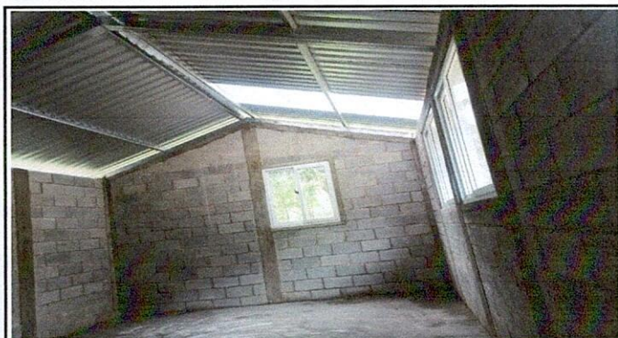
Foto 3: Mejoramiento de aula con sus paredes y ventanales
