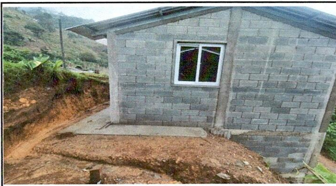
Foto 2: Muro de contención base del aula tipo portico.
